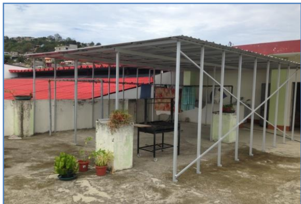
Una tettoia sulla terrazza della casa per attività parrocchiali
